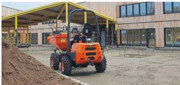
Le chantier du groupe scolaire Kerisbian, à Brest.
